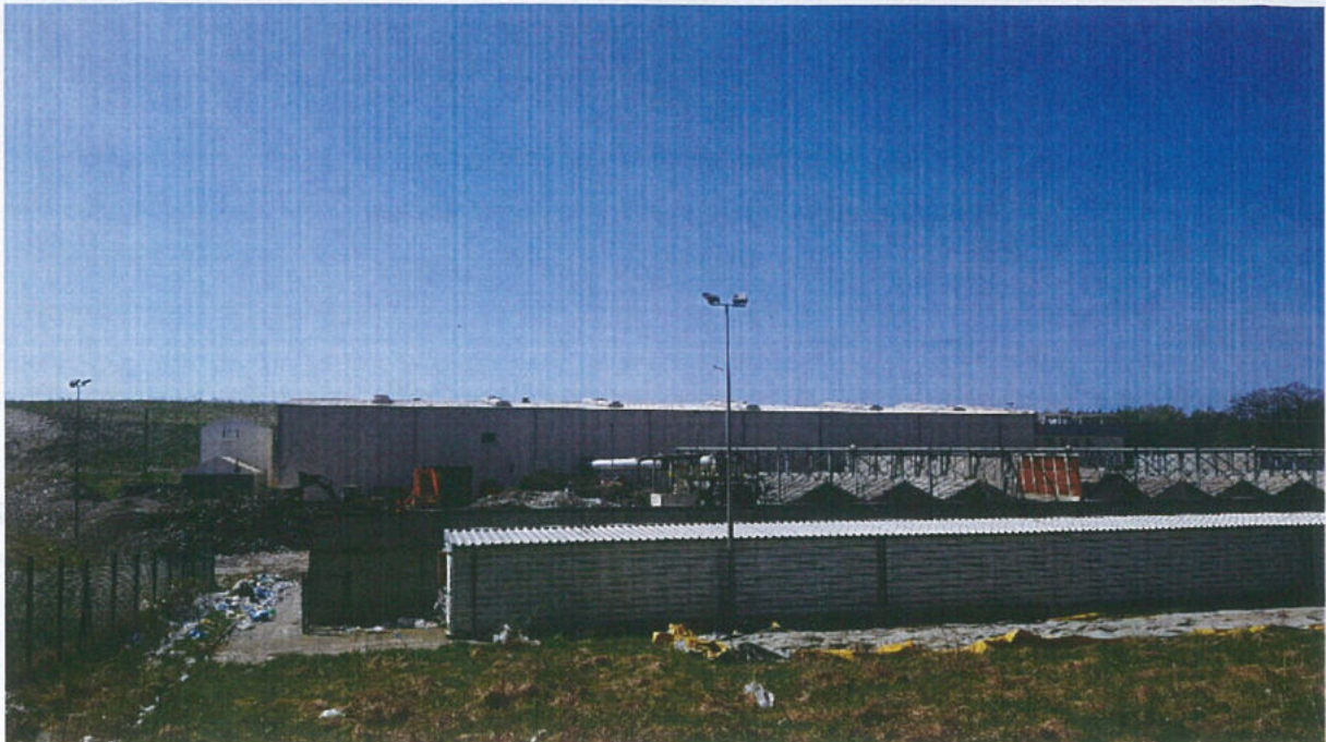
Fotografia 1 Widok na wentylatorownię intensywnego dojrzewania – [kwiecień 2018]
